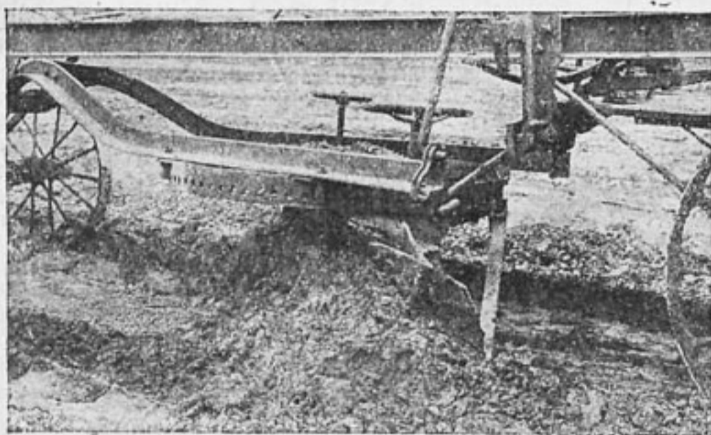
Механизация дорожных работ. Отвал земли
